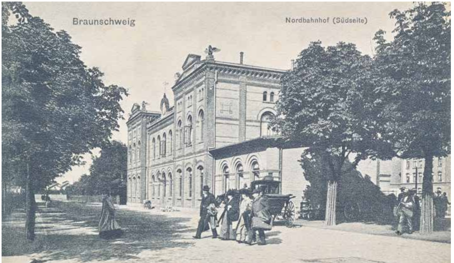
1907 – auch Personen wurden befördert.
