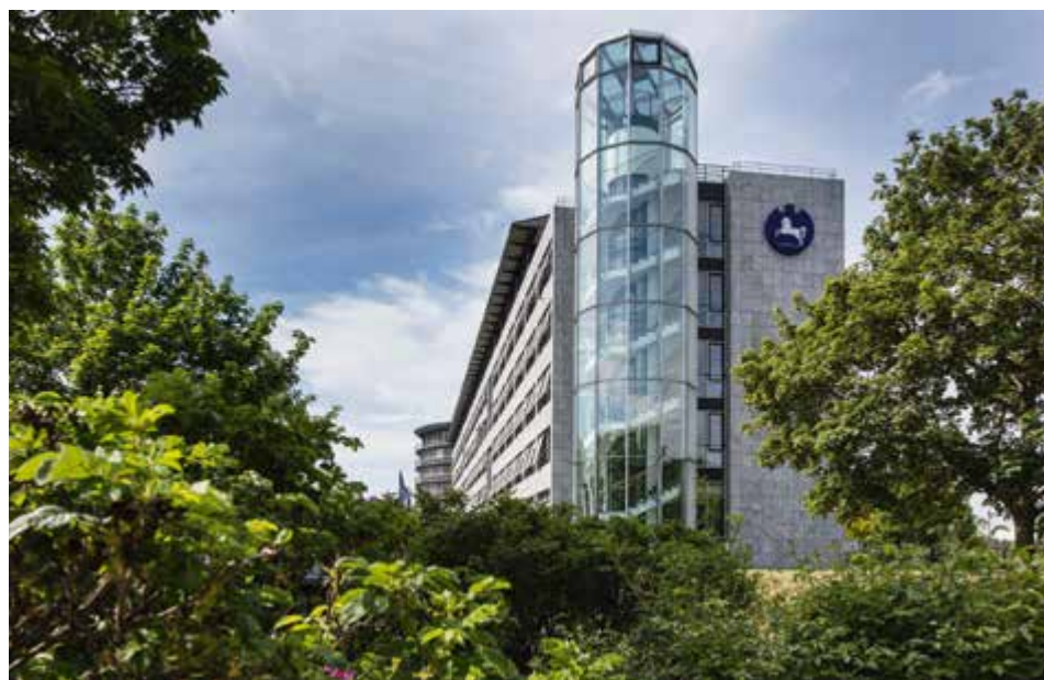
Die Öffentliche Facility Management GmbH in der Theodor-Heuss-Straße.
