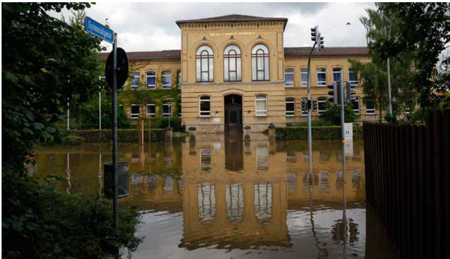
Die Große Schule am Rosenwall war tagelang vom Hochwasser betroffen. Die Kellerräume wurden geflutet und müssen nun saniert werden.
