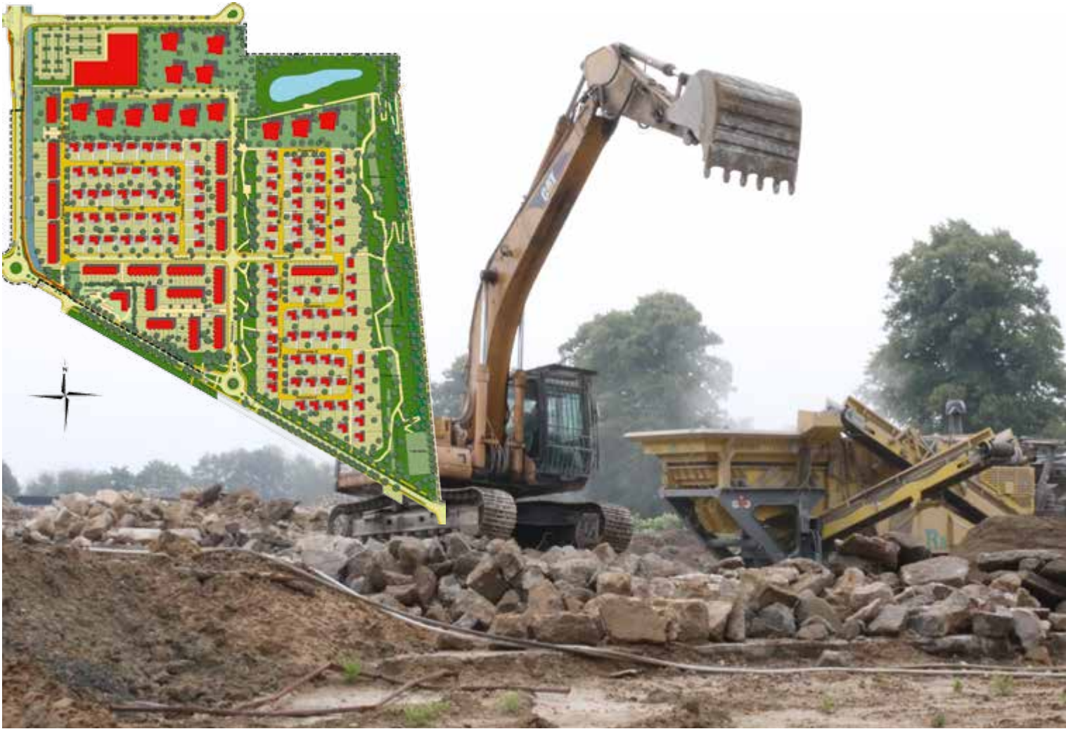
Abrissarbeiten in der der ehemaligen Heinrich-der-Löwe-Kaserne. Demnächst entsteht hier ein neues Baugebiet.
