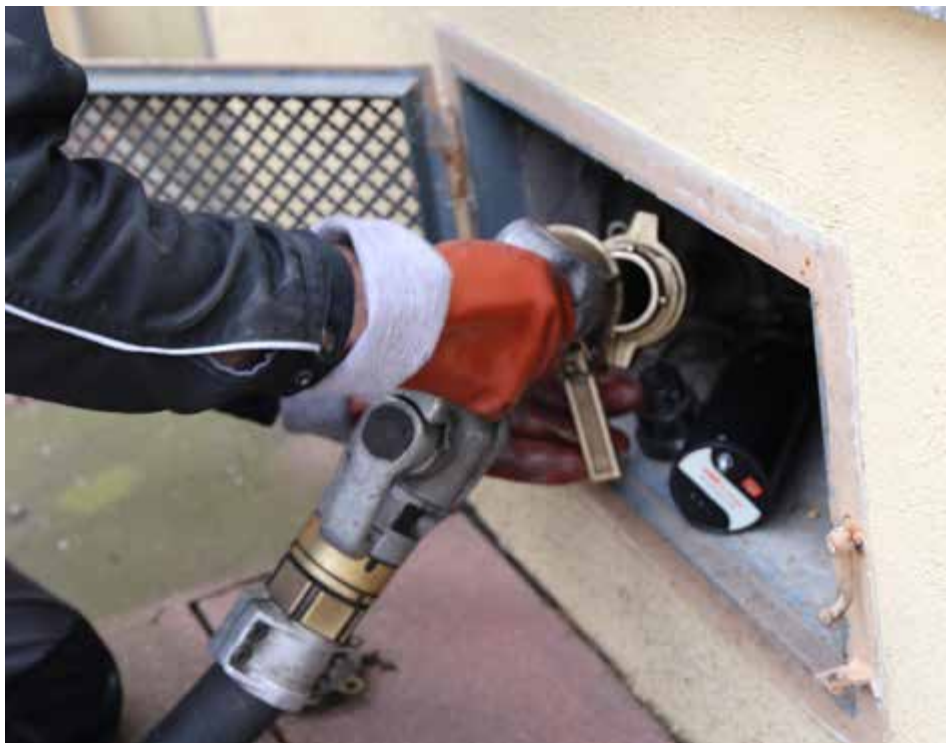
Eigentümer müssen für den ordnungsgemäßen Zustand ihrer Heizöltanks sorgen.
