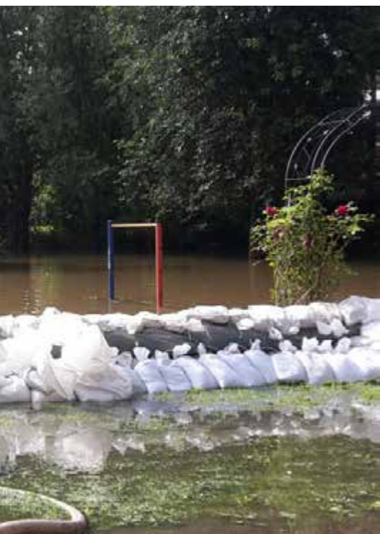
eine Barriere aus Sandsäcken errichtet.
