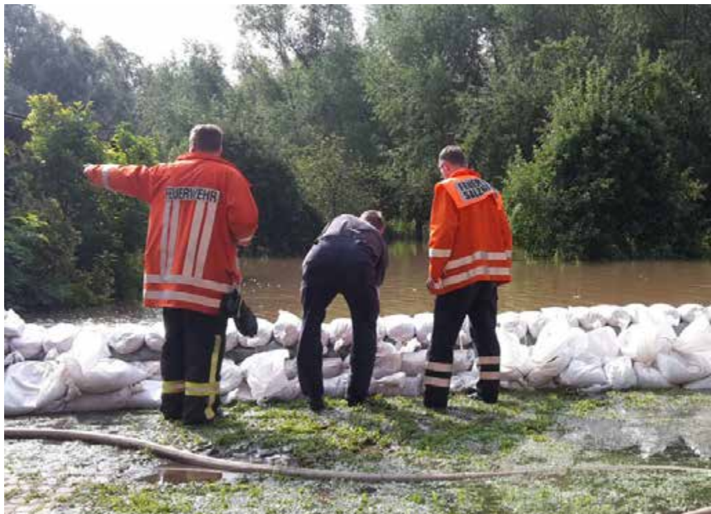
Wassermassen haben einen Garten in Wolfenbüttel vollkommen überflutet. Die örtliche Feuerwehr hat
