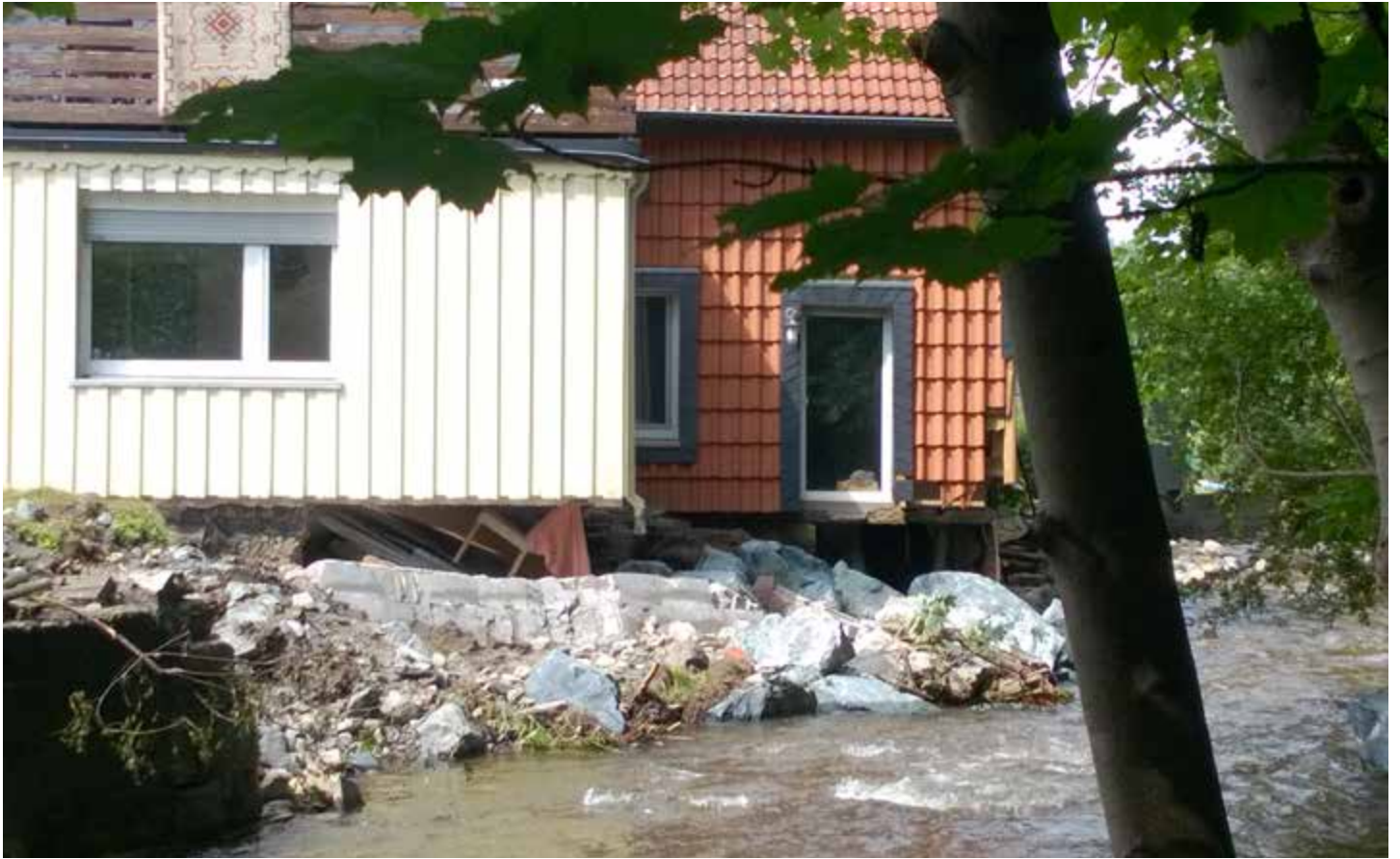
Schaden in der Breiten Straße in Bad Harzburg. Auch Rhüden bzw. Seesen und Hornburg waren besonders stark getroffen.
