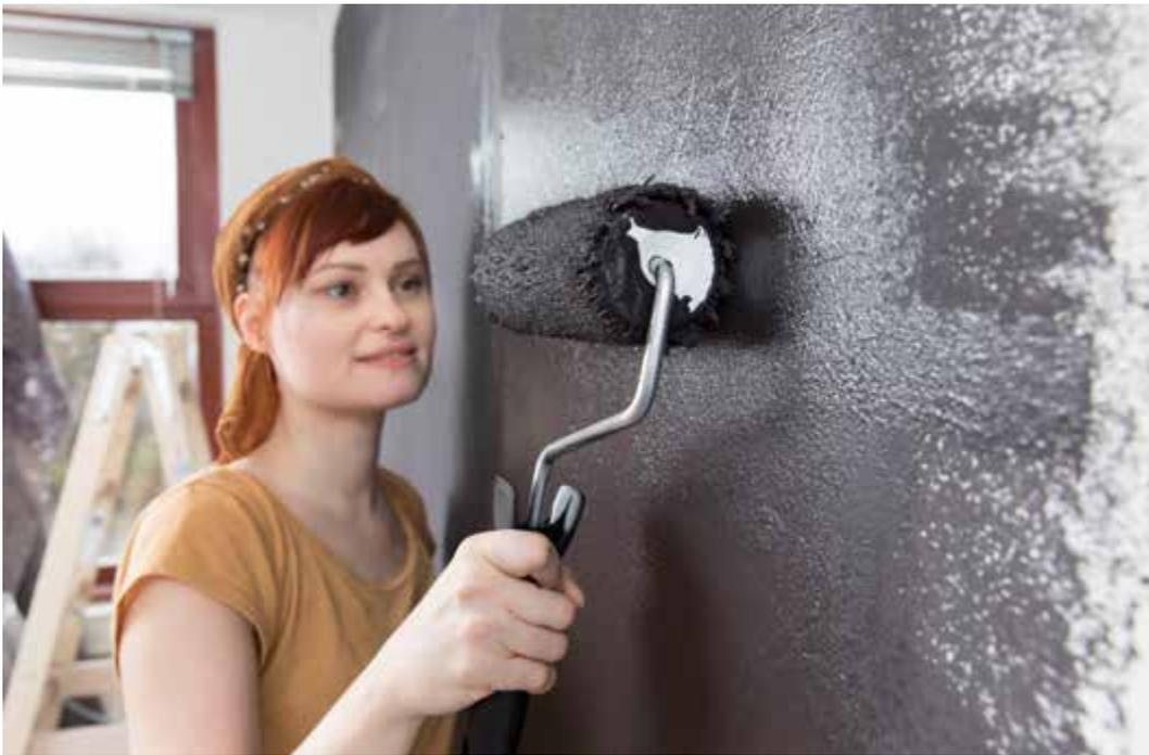
Praktisch: Die Grundierung für Innenwände „Safe Shield“ schirmt elektromagnetische Strahlung ab.
