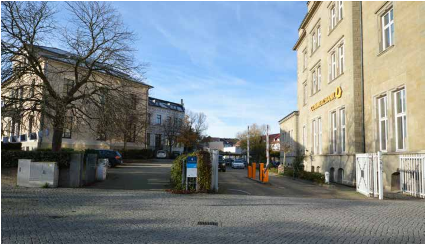
2019 – Haus, Bassin und Fische sind Geschichte, es entstanden Kundenparkplätze der Commerzbank.
